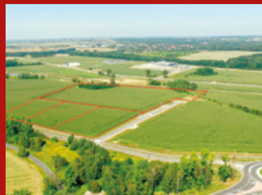
Kolejni inwestorzy i kilka tysięcy nowych miejsc pracy to oczekiwane efekty poszerzenia zabrzańskiej strefy ekonomicznej
